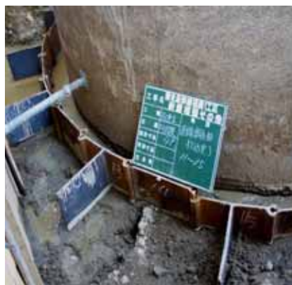
写真-4 打設完了
