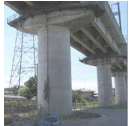
写真-5 補強完了
