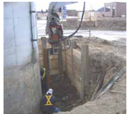
写真-3 打設状況
