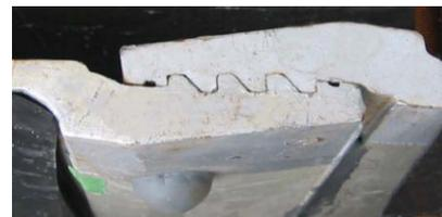
写真-1 かみ合わせ継手の断面
