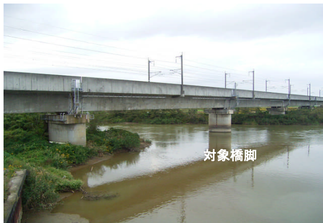
写真－1 対象橋脚の全景
