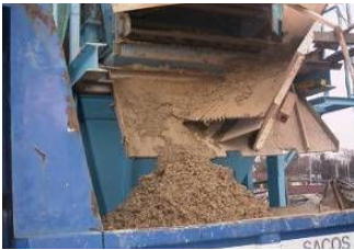
写真-2 排土状況
