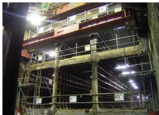
図3: ハーモニカ工法 掘削完了状況
