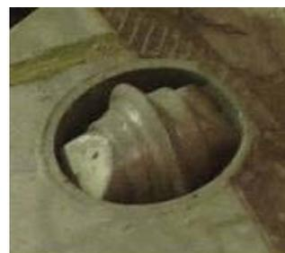
写真 - 3, 4 岩盤部掘削前後のディスクカッタ
