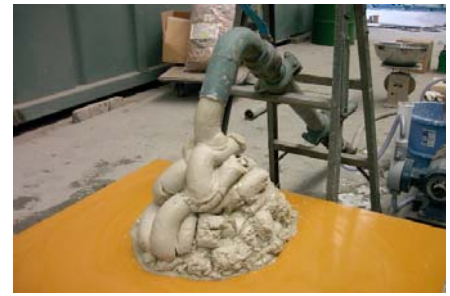
写真-1 充填材混合状況
