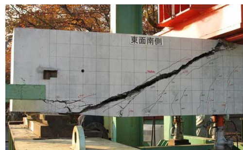
写真-2 せん断破壊状況 (No.1)
