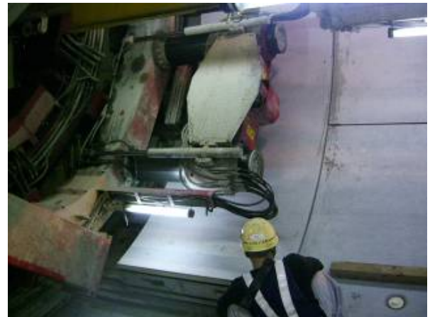
写真-4 剥落防止セグメントの組立て状況
