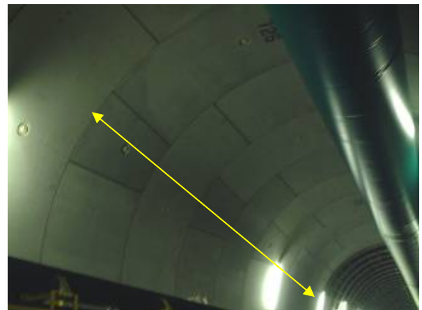
写真-5 施工後の坑内での状況
