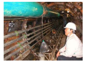
写真-4 B現場適用試験状況 (漏風量サンプリング)
