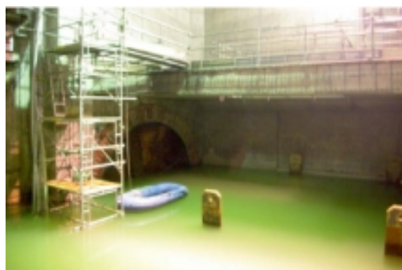
写真－1 マシン到達後の貯水状況
