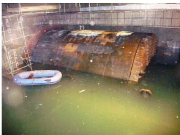
写真－2 マシン引抜き後の排水状況
