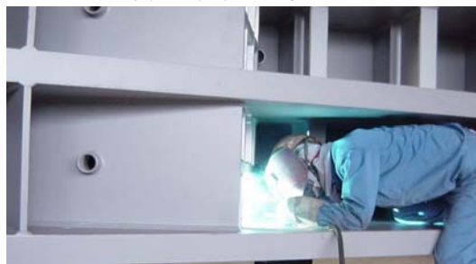
写真-2 定着金物溶接状況
