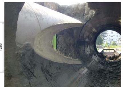
写真-3 切削完了後
