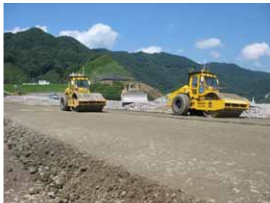
写真-2 振動ローラ転圧時にデータ取得
