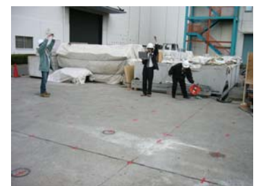
写真1 格子状測線計測状況
