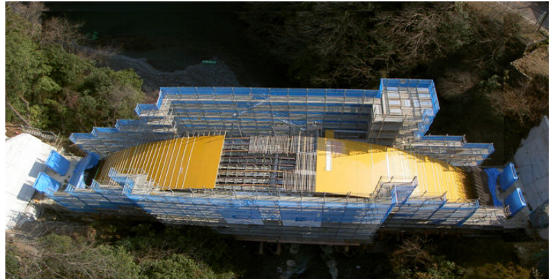
写真-1 矢柄橋A橋アーチリブ施工状況
