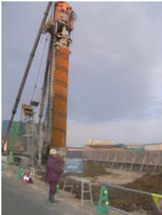
写真2 基礎杭打設工（2号機）
