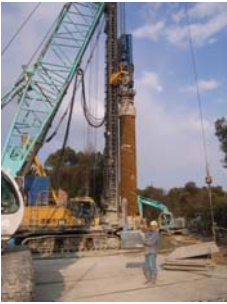
写真1 基礎杭打設工（1号機）
