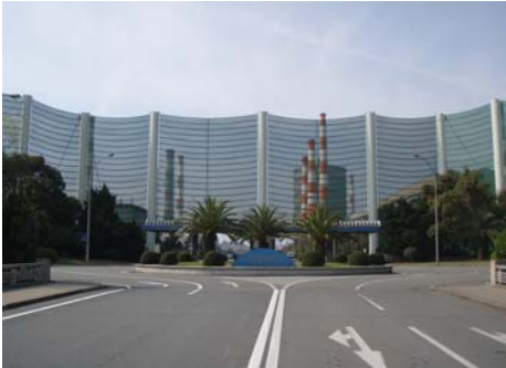
写真3 防じんネット設置完了（正門前）
