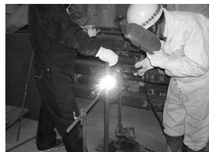
写真－2 PC 鋼棒と鉄筋の溶接状況
