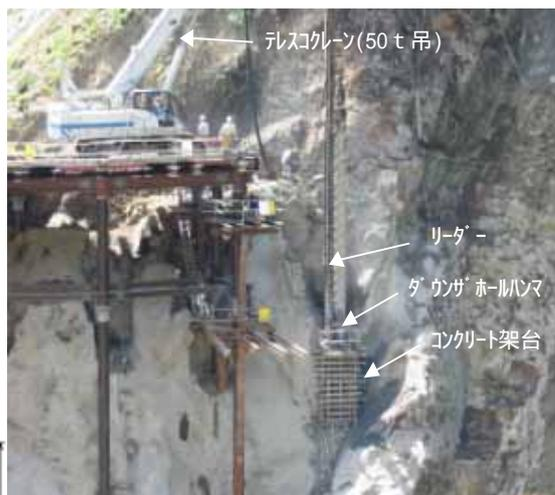
写真 1 ダウンザホールハンマ削孔状況
