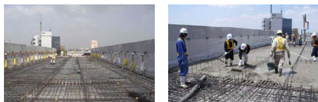
写真-2 鉄筋組立・コンクリート打設状況
