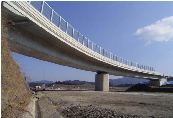
写真－1 完成写真
