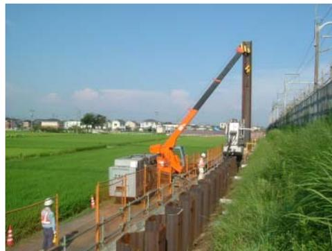
図-3: 岐阜県内施工箇所におけるSP圧入状況
