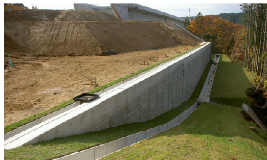
写真-1 補強土壁工法の現場
