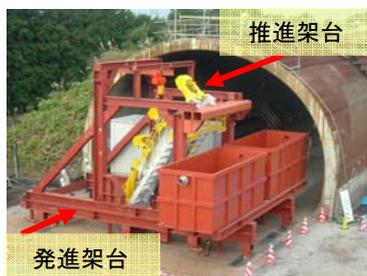
図 2-1 推進架台・発進架台
