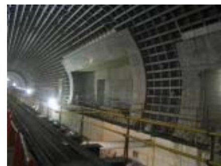
(b) 切開き部構築完了状況
