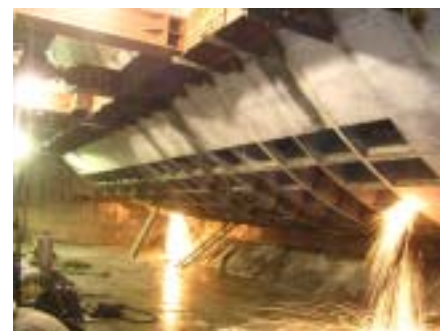
(a) セグメント切断状況
