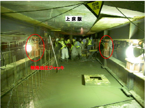
写真-1 ジャッキ設置状況
