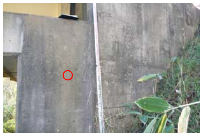
写真-1 A橋橋台堅壁側面部分
