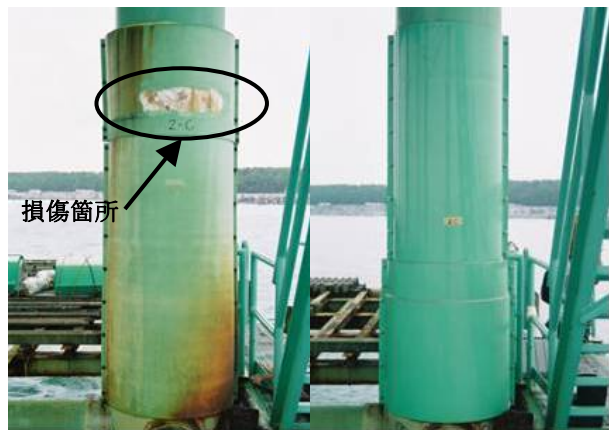
図 4 FRP 保護カバー材 (左: 標準仕様 右: 耐衝撃仕様)
