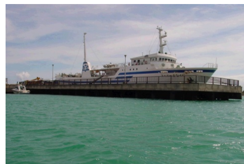
写真-1 電気防食対象栈橋
