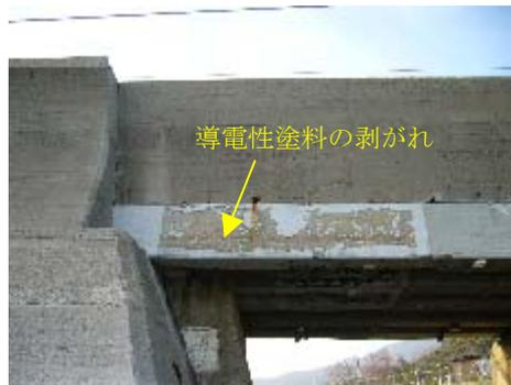
写真-1 導電性塗料の剥がれ
