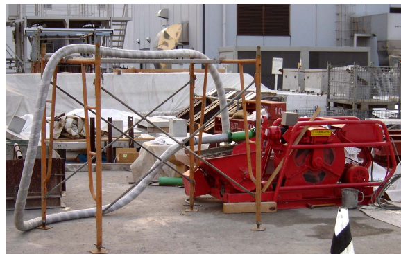
写真1 ポンプ圧送の状況
