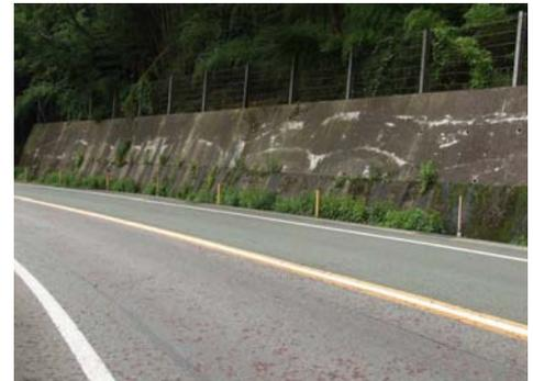
写真-2 S 擁壁におけるひび割れ状況
