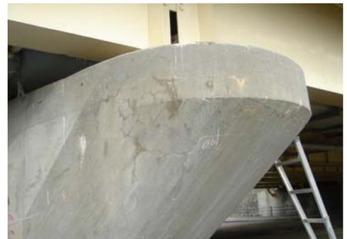
写真-1 M橋橋脚におけるひび割れ状況
