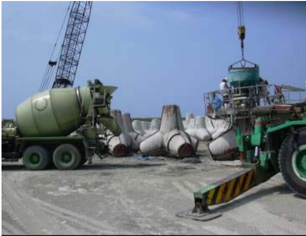
写真-1 コンクリート打設状況
