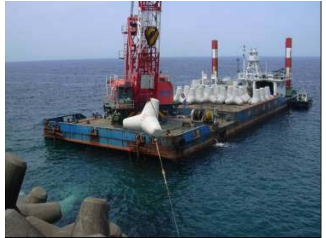
写真-2 海上据付状況
