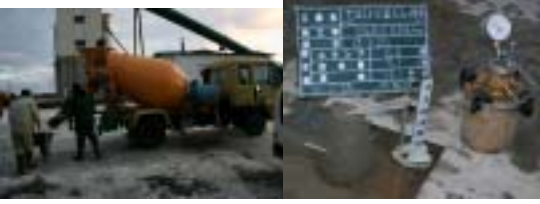
写真 1 プラントによる混練り状況
