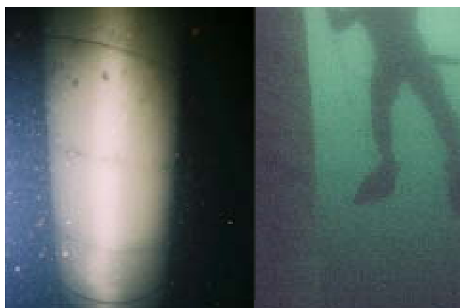
写真-2 潜水夫による段落し部の水中巻立工法
