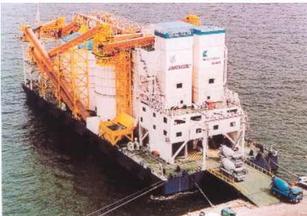
写真-2 コンクリートプラント船
