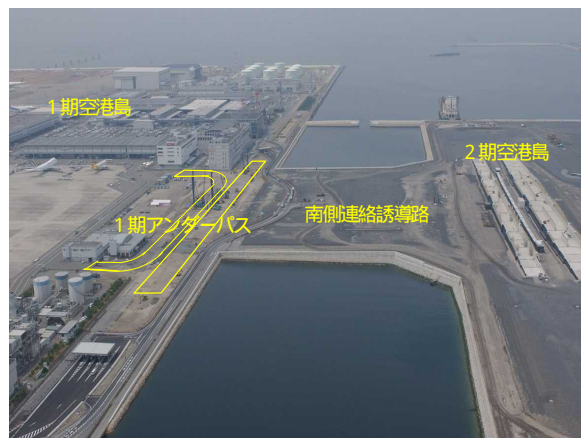
写真 - 1 1 期アンダーパスと南側連絡誘導路
