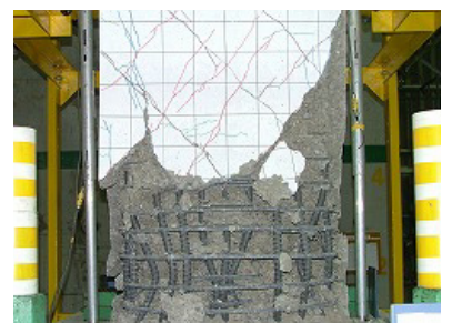
図 6 損傷状態（載荷面，載荷④）
