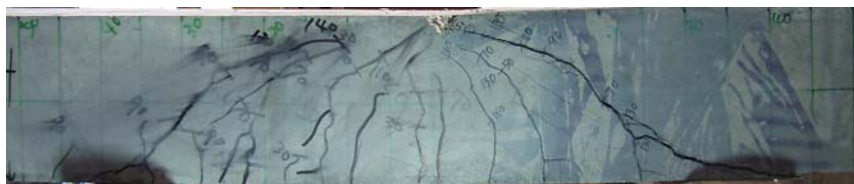
図－3 ひび割れ状況（軽量1種：40N/mm²）
