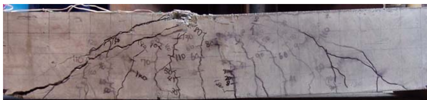
図－4 ひび割れ状況（普通コンクリート：55N/mm²）
