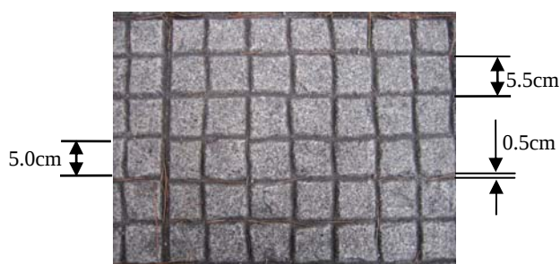
写真-2 ブロック系舗装 (目地間隔 5.5\text{cm} )
