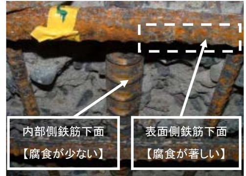
写真 1 鉄筋腐食状況(例)
