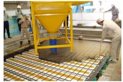
写真-1 UFC床版の打設状況
