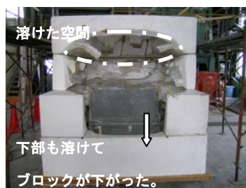
写真-1 解体時の断熱材
