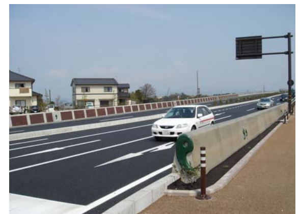
写真-4 完成写真
