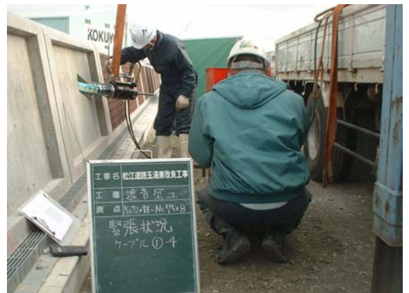
写真-2 緊張状況
