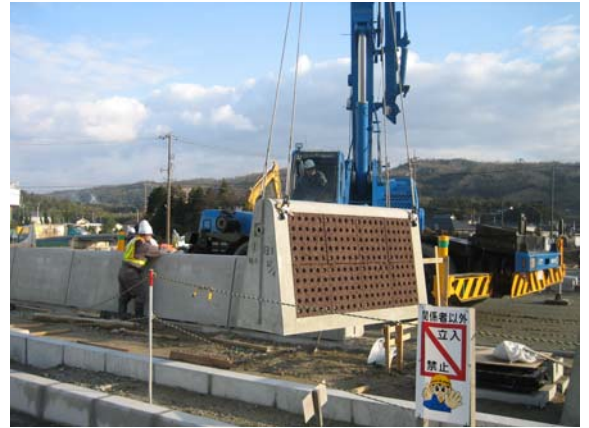
写真-1 据付状況
