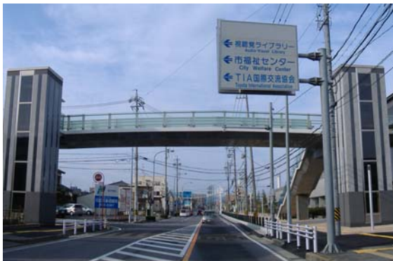
写真-4 完成後の側面写真
