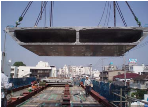
写真-2 UFCによるプレキャストセグメントの架設
