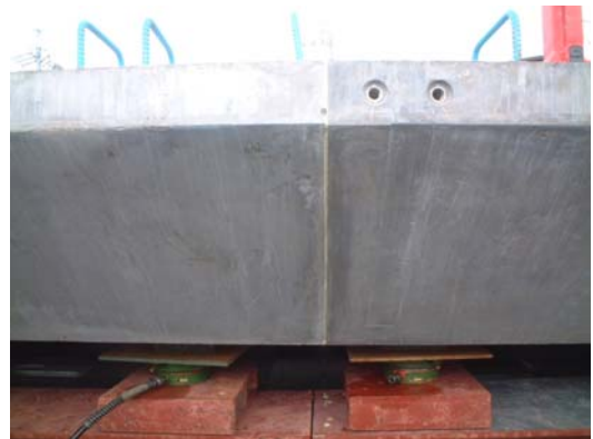
写真-3 ドライジョイントの接合部
