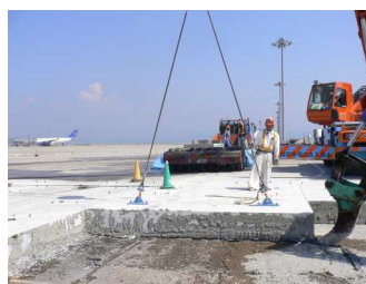
写真1 抜き取り状況
