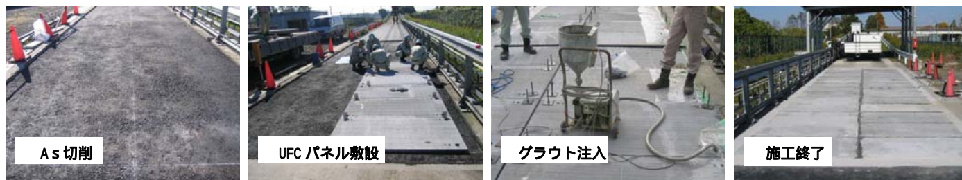
図-2 試験舗装の施工の状況
