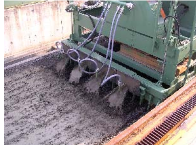
写真-1 セメントスラリー散布状況
