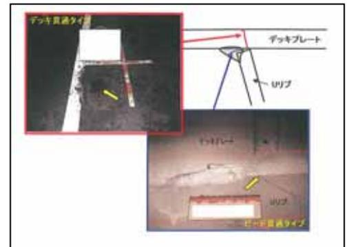
図-1 鋼床版Uリブ溶接線のき裂損傷
