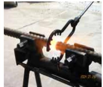
写真-1 ガス圧接状況
